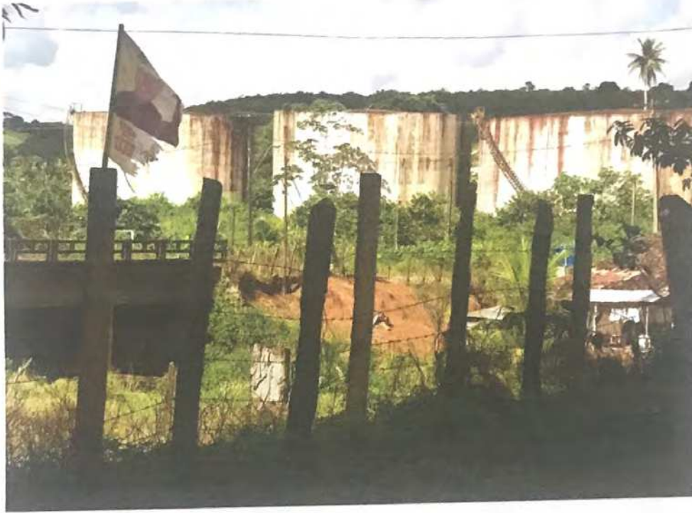
PRÉDIOS INDUSTRIAIS E SILO
