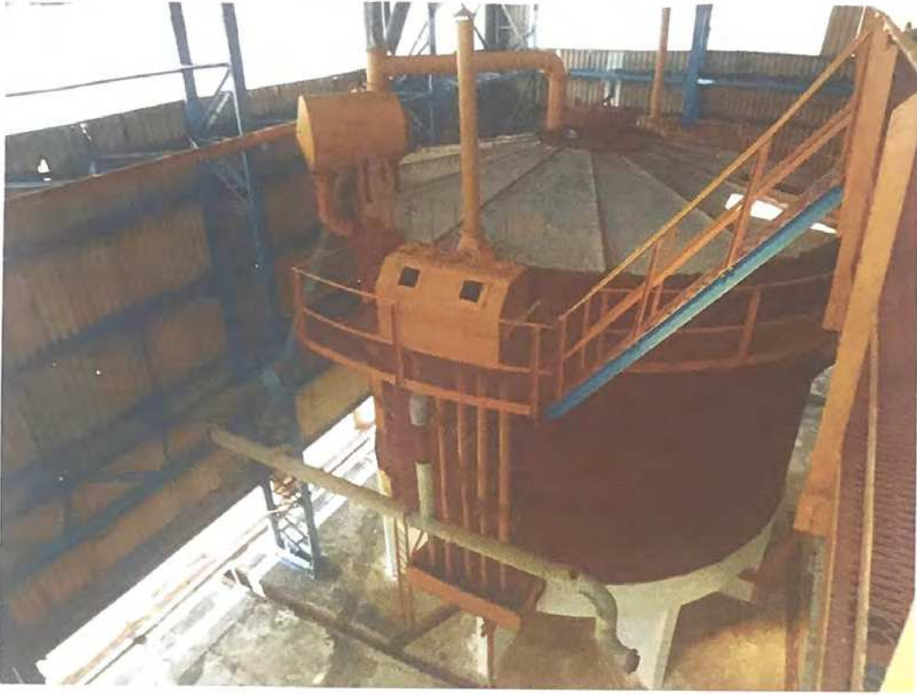
PRÉDIO CASA DE FORÇA
